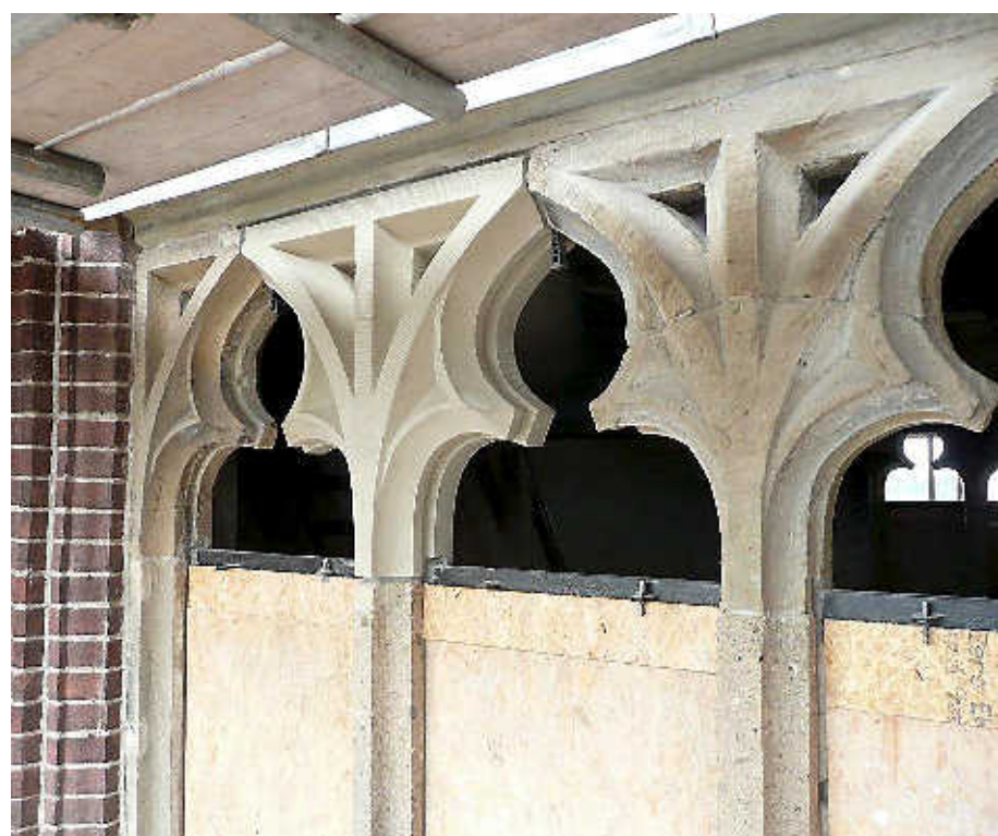
Sommige montants worden in z'n geheel vervangen.
