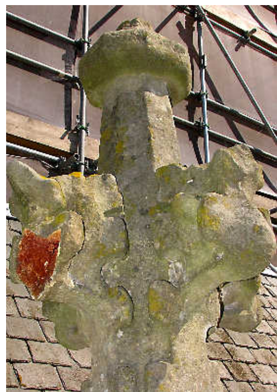
De pironnen op de ornamenten brokkelen soms af, en ook dit wordt hersteld.
