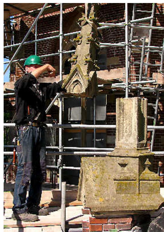
Sjaak Bes lift een pinakel omhoog. Het 'schouderstuk' volgt hierna.
