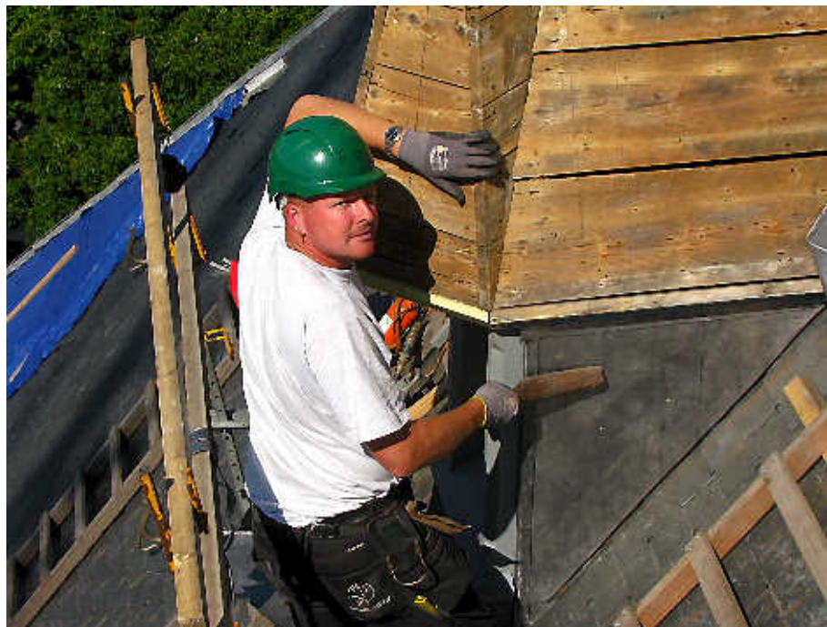
Loodbewerker Frans Stam bezig aan een dakkapel.
