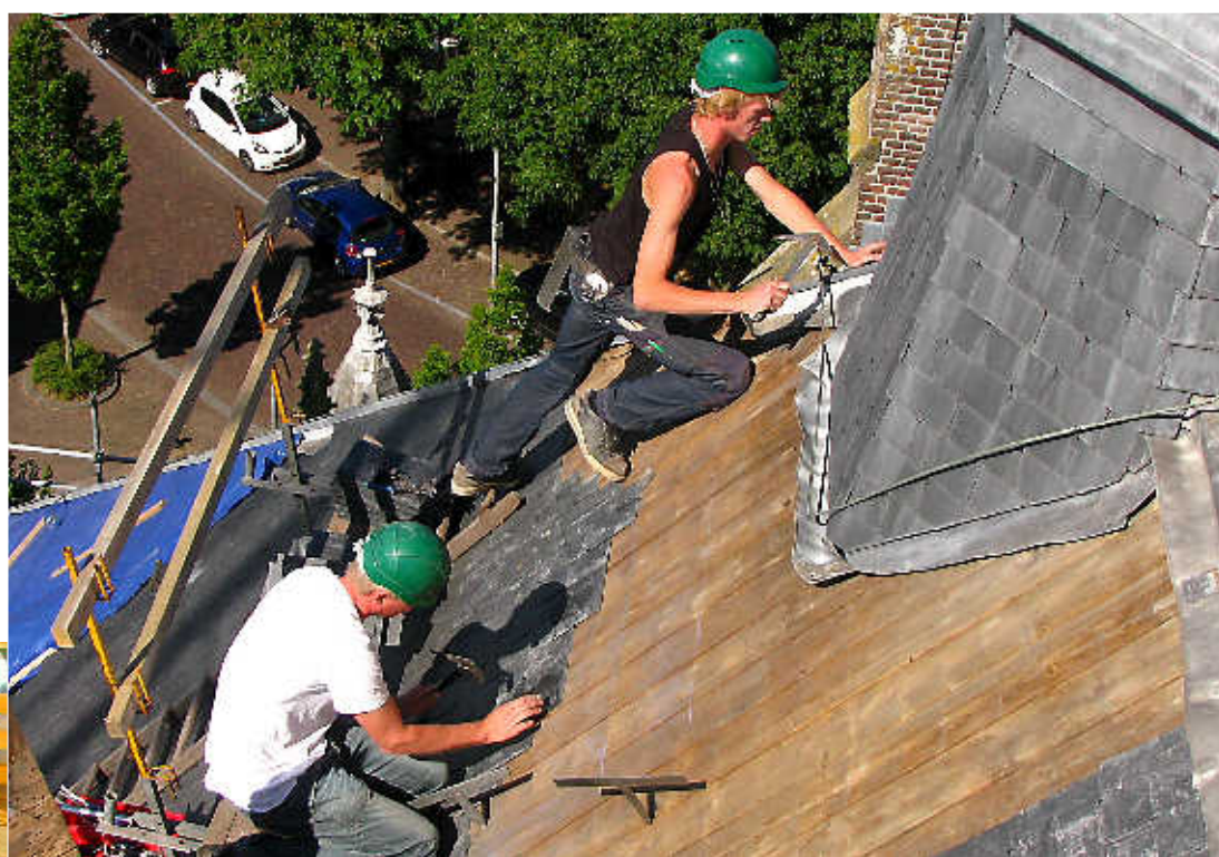
Chris Pronk (l) en Chiel de Ruijter op 25 meter hoogte bezig met leidekken.
