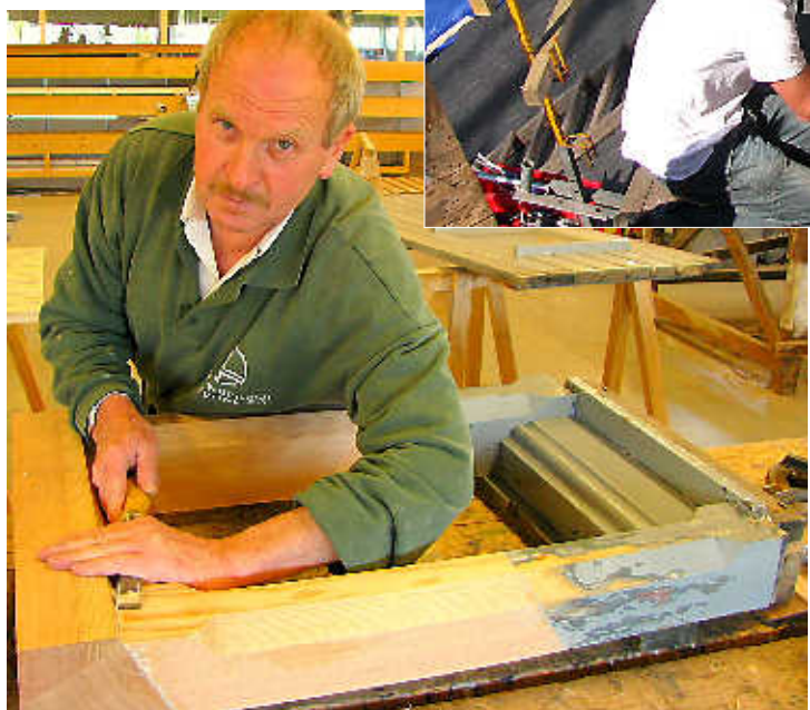
Timmerman Paul van Wegen repareert in de werkplaats een kozijn van een van de zestien dakkapellen.
